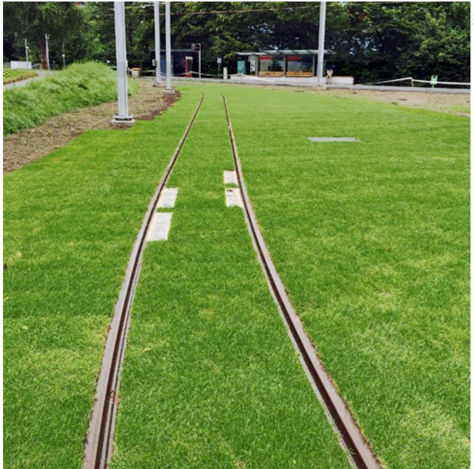
Alles im grünen Bereich: Die Gleisschleife nach der Verlegung der Rasenteppiche.
