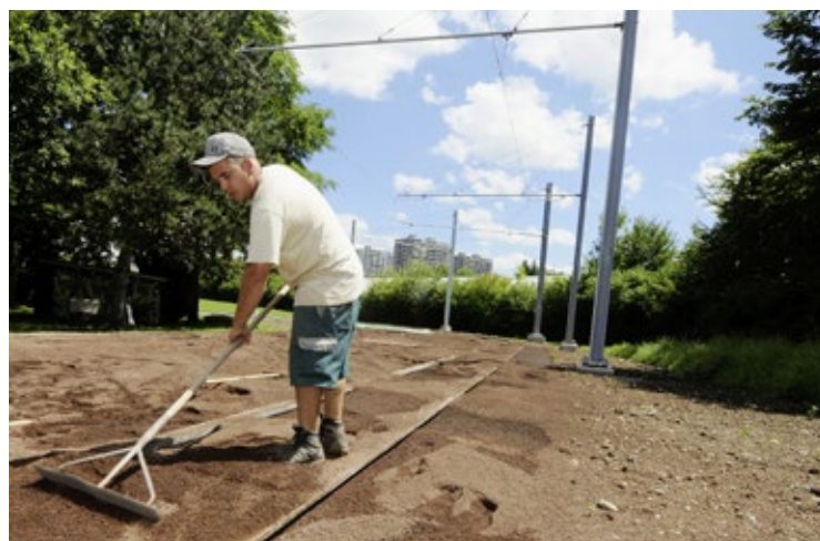
Über den Versorgungsleitungen wird eine doppelte Vliesschicht angebracht. Sie verteilt das Wasser gleichmässig über die ganze Fläche (ganz oben). Neben den Tropfrohren sind lediglich einige Entleerungsrohre (blauer Stutzen) notwendig (oben links). Das Substrat wird mit Handarbeit verteilt (oben rechts).
