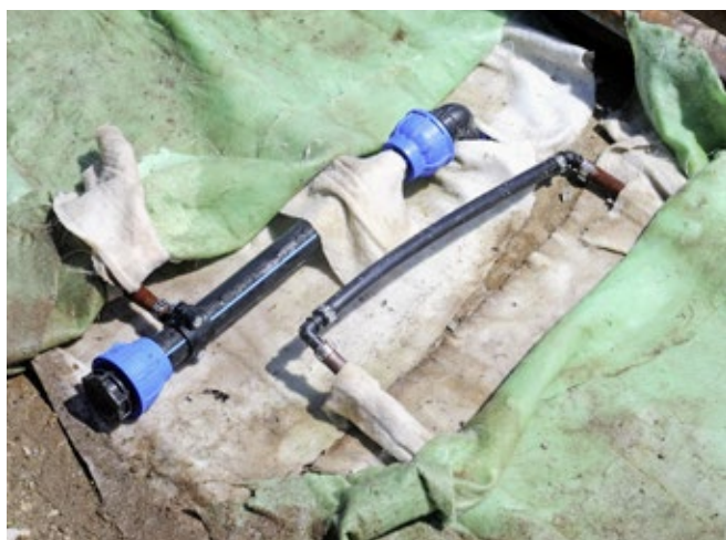
Über den Versorgungsleitungen wird eine doppelte Vliesschicht angebracht. Sie verteilt das Wasser gleichmässig über die ganze Fläche (ganz oben). Neben den Tropfrohren sind lediglich einige Entleerungsrohre (blauer Stutzen) notwendig (oben links). Das Substrat wird mit Handarbeit verteilt (oben rechts).
